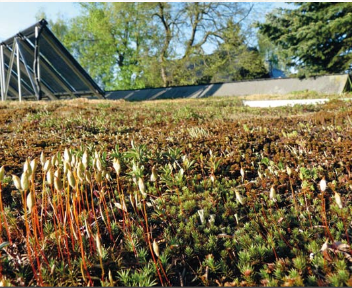
Dachbegrünung mit Moosen und Mauerpfeffer (Kleines Vorwerk bei Sayda)
