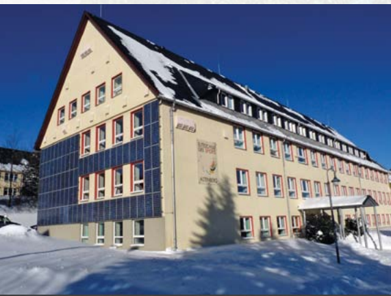
Neue Fledermausquartiere am Gymnasium Altenberg als Ersatz für die Quartiere an der abgerissenen alten Turnhalle
