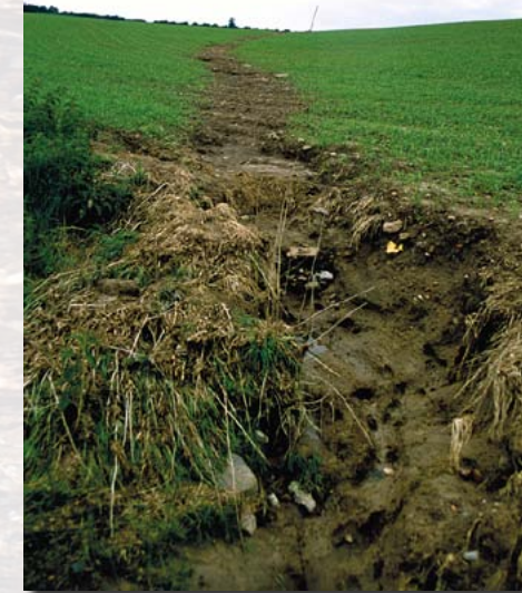
Erosion nach einem Gewitter am Lerchenberg
