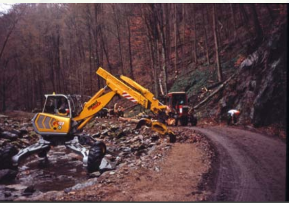
Bachbett als Baggerpiste
